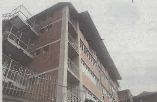
Il Baruffi di Mondovì: demolizione e ricostruzione previste entro luglio 2023
